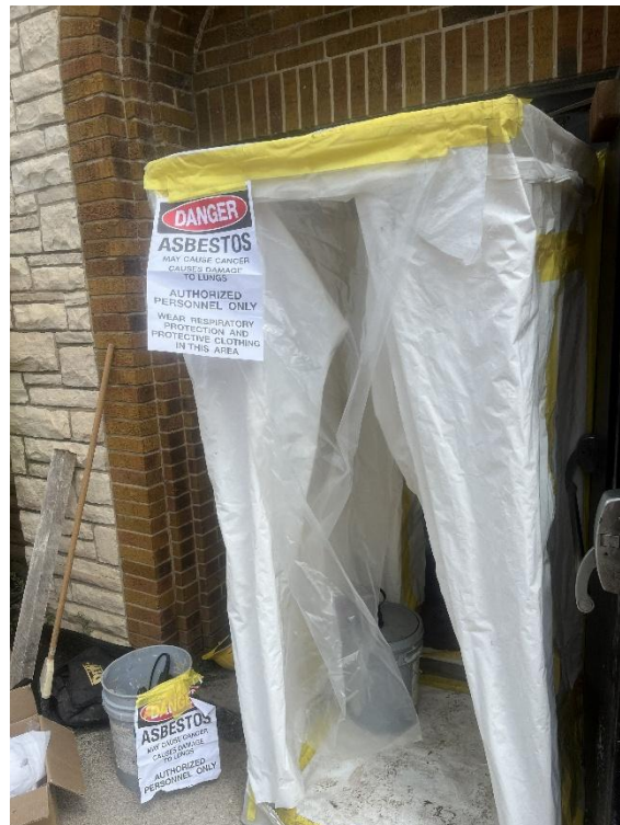
STR 100 asbestos abatement.
